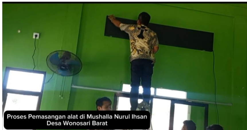
Gambar 4. Proses Pemasangan Running Text
