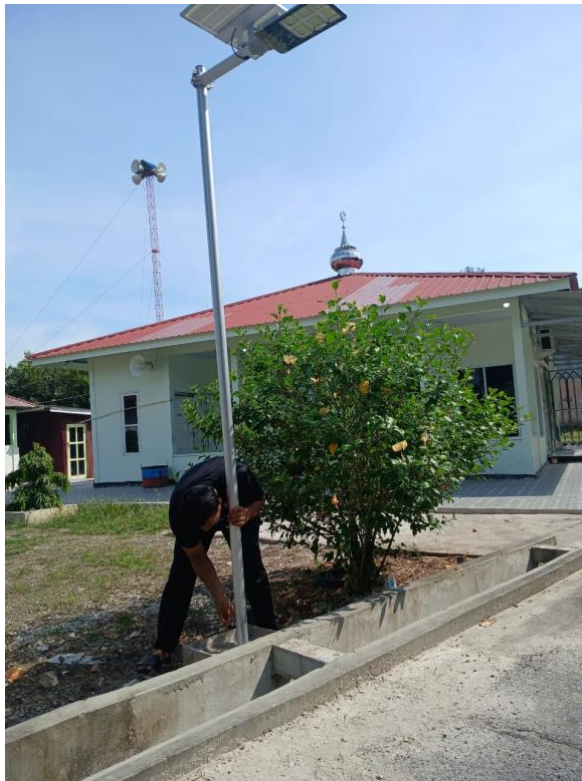
Gambar 4. Pemasangan tiang
