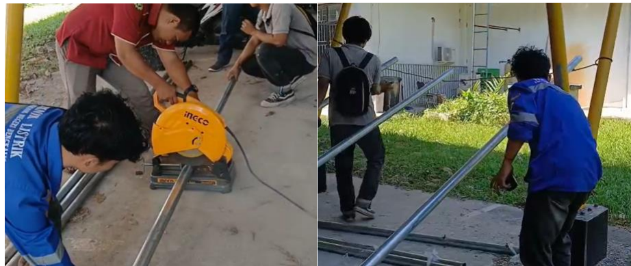
Gambar 2. Pembuatan tiang
