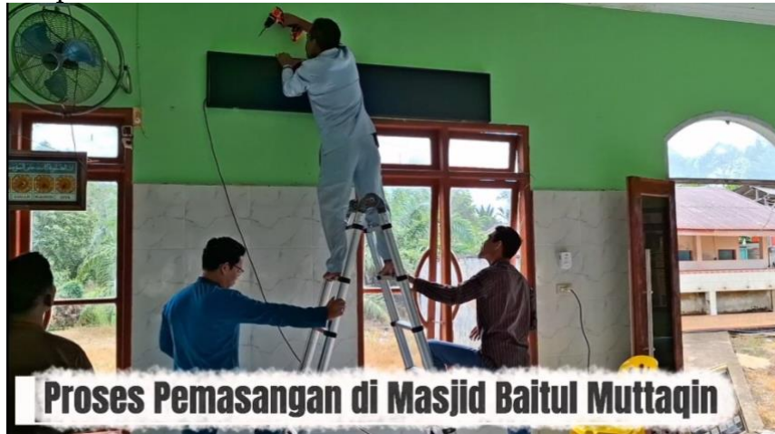
Gambar 4. Proses Pemasangan Running Text
