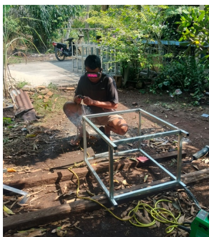
Gambar 5. Proses Pembuatan Meja dan Kursi Belajar Santri Pondok Pesantren Al Huffazh Bengkalis.
