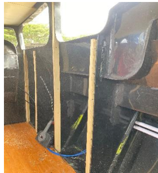
Pemasangan penegar untuk playwood
