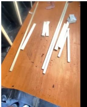
Pemasangan Vinil untuk lantai
