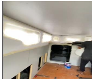
Pemasangan full HPL
