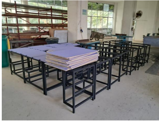
Gambar 5. Pengecatan Material Besi dan Multiplex (Faisal Ananda, 2025)
