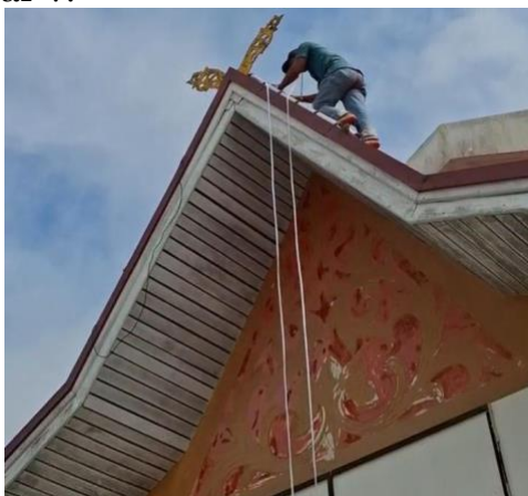
Gambar 5. Pemasangan LED Strip Bagian Atap Bangunan
