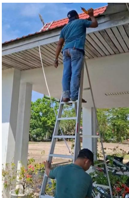
Gambar 6. Pemasangan LED Strip Bagian Lisplang
