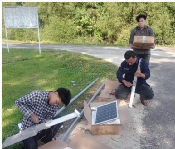
Gambar 2. Perakitan unit lampu tenaga surya
