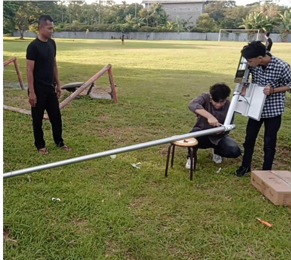
Gambar 3. Pemasangan unit lampu pada tiang
