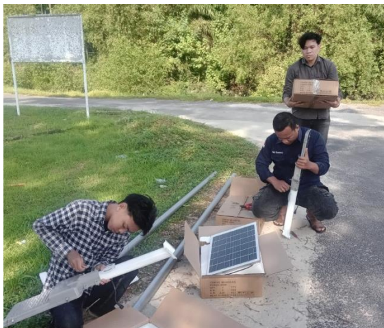
Gambar 2. Perakitan unit lampu tenaga surya
