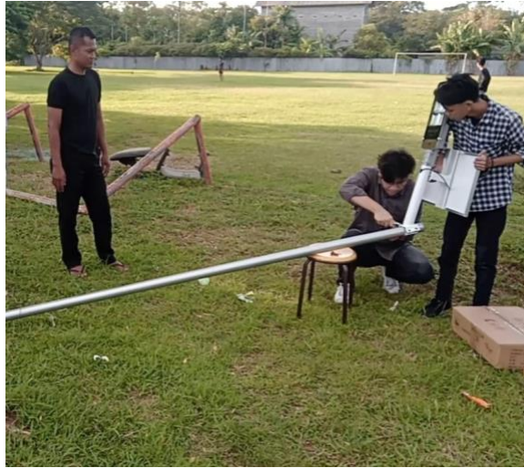
Gambar 3. Pemasangan unit lampu pada tiang
