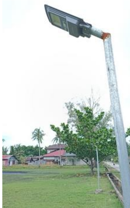
Gambar 5. Hasil Pemasangan Lampu PLTS (Jefri Lianda dkk, 2024)
