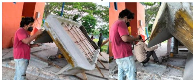
**Gambar 8** Proses pendempulan lambung kapal
