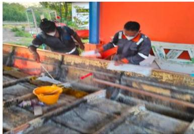
**Gambar 5** penambahan paku di lapisan ketiga
