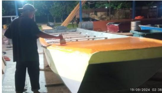
Gambar 9 Pengecatan lambung kapal katamaran
