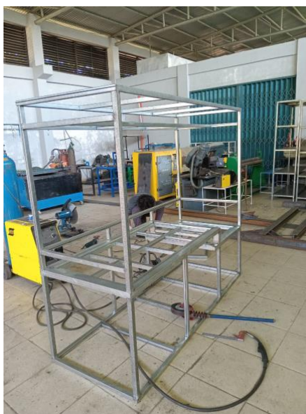
Gambar 5. Pemasangan keseluruhan Rangka utama (sumber : foto dokumentasi)
