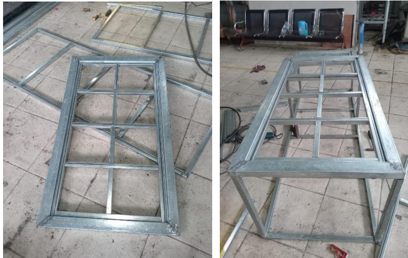
Gambar 4. Pemasangan Rangka bawah (sumber : foto dokumentasi)
