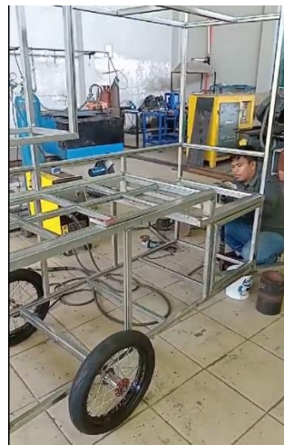
Gambar 7. Pemasangan roda gerobak (sumber : foto dokumentasi)
