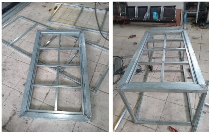
Gambar 4. Pemasangan Rangka bawah (sumber : foto dokumentasi)
