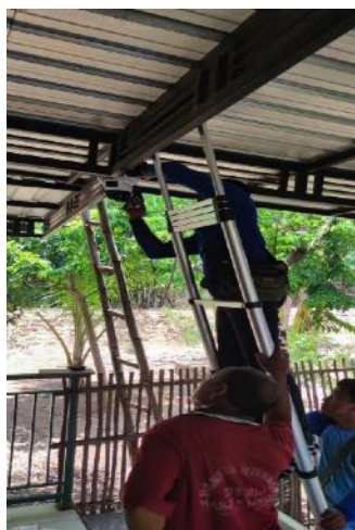
Gambar 3.3 Pemasangan Hardware CCTV
