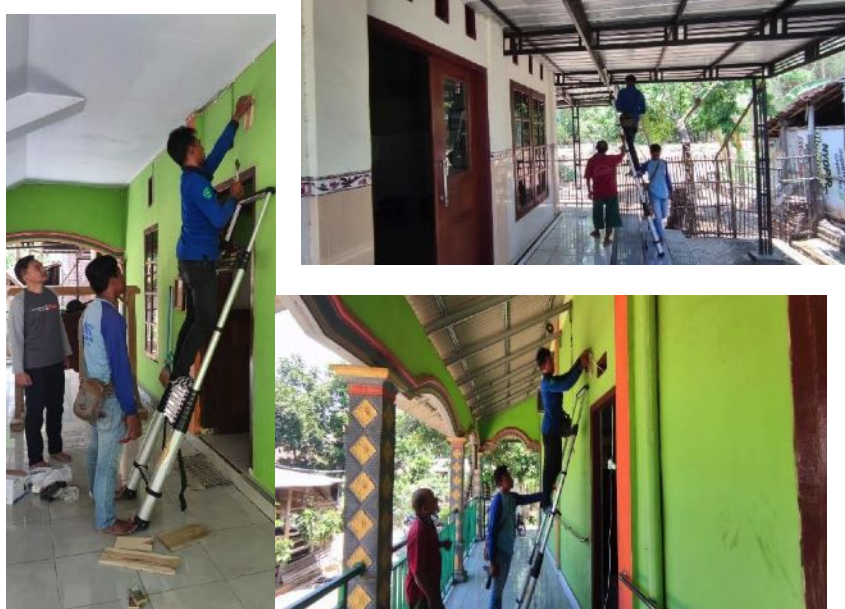
Gambar 3.2 Pemilihan Tempat Pemasangan Hardware CCTV
