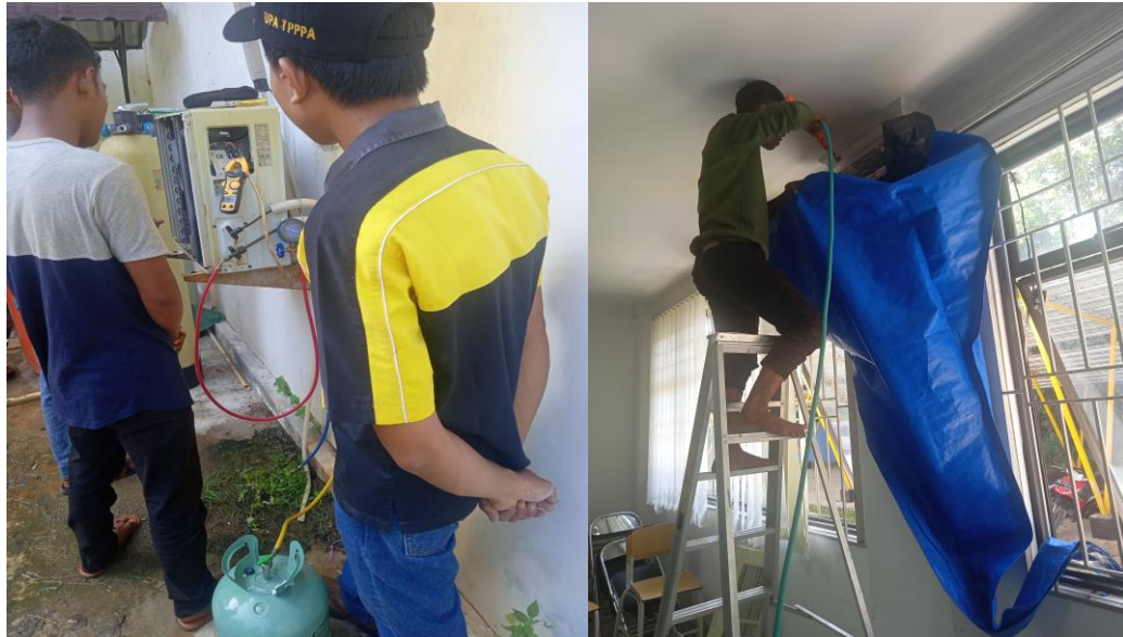
Gambar 5. Praktik Perawatan Unit Indoor dan Outdoor
