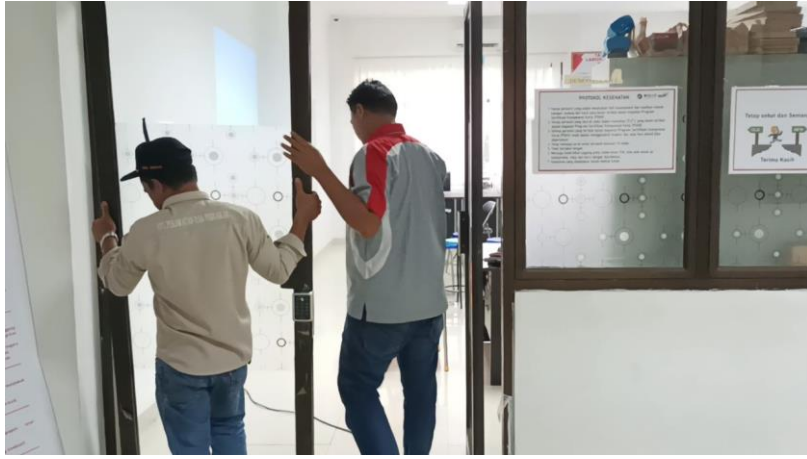
Gambar 6. Pemasangan Kembali Pintu
