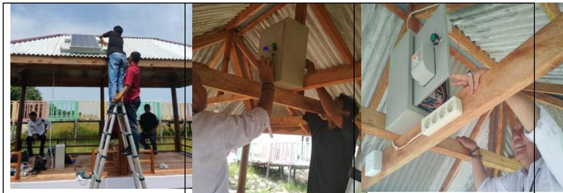
Gambar 8. Proses Pemasangan Instalasi Pada Bangunan Gazebo
