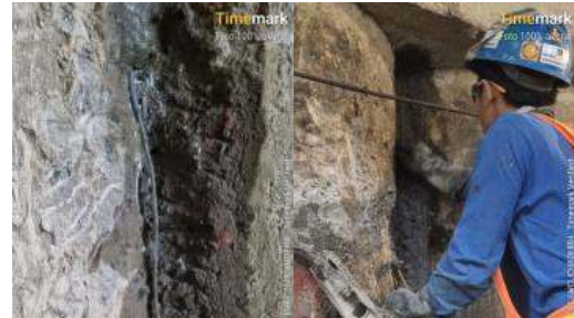
Gambar 6 Pemasangan Saluran Drainase & Mortar
