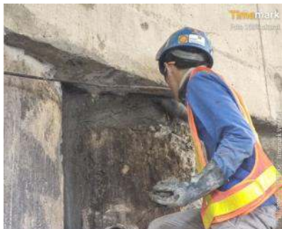
Gambar 17 Pengaplikasian Mortar pada Honeycomb
