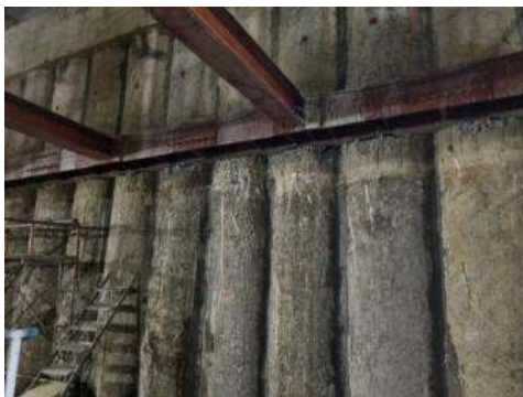
Gambar 2 Kondisi Secant Pile pada Basement
