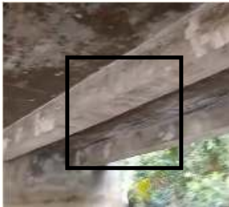
Gambar 5 Balok Masih Dalam Kondisi Baik
