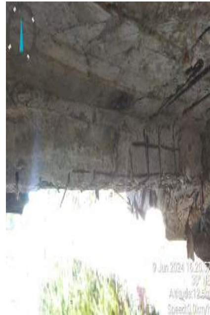
Gambar 3 Kondisi pada balok jembatan Sumber : (Dokumentasi Skripsi 2024)
